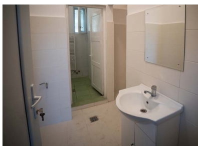
Na de verbouwing
