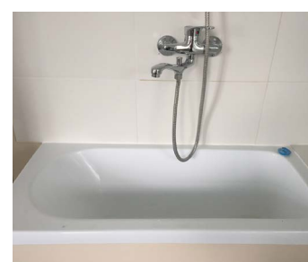
Na de verbouwing
