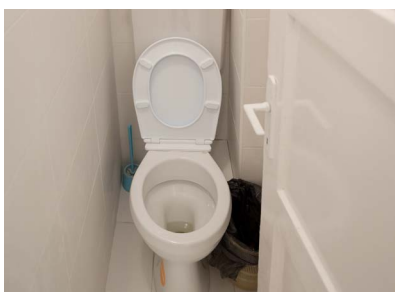
Na de verbouwing
